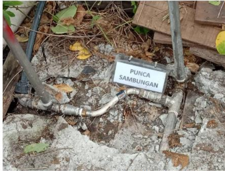
被告所经营的冷冻食品工厂「非法接驳水源到工厂内作为各类用途。」(森水务公司提供)
